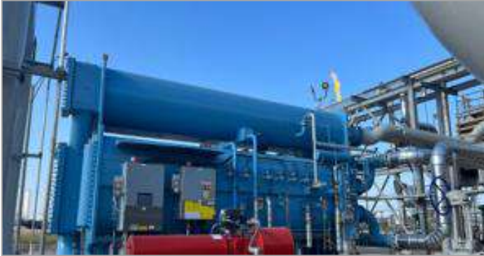
1319 TR Máy làm lạnh hấp thụ đốt hơi nước một hiệu quả Nhà sản xuất hóa chất, Hoa Kỳ
