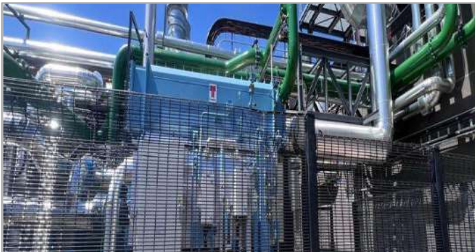
Máy làm lạnh hấp thụ áp suất cực thấp 342 TR, Cơ sở chế biến đồ ăn nhẹ Nam Phi
