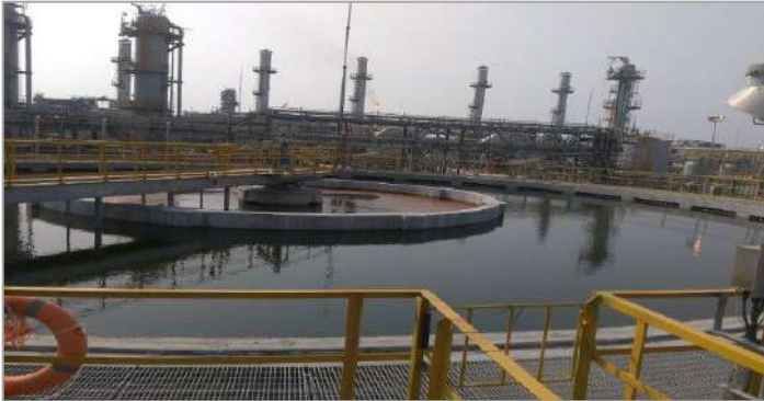
63 MLD WTP (nhà máy PT (bể lắng) công suất 2x1320 m 3 /giờ DMF công suất 10x255 m 3 /giờ) Công ty xây dựng và kỹ thuật Indonesia
