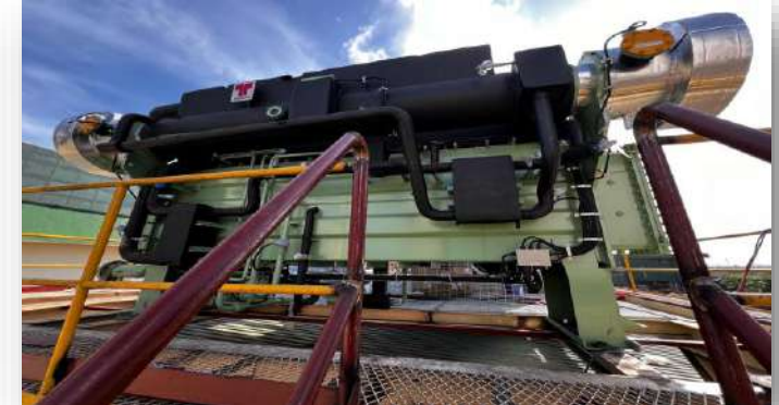
Máy làm lạnh điều khiển bằng dầu nhiệt 240 TR, Nhà sản xuất ván dăm Malaysia
