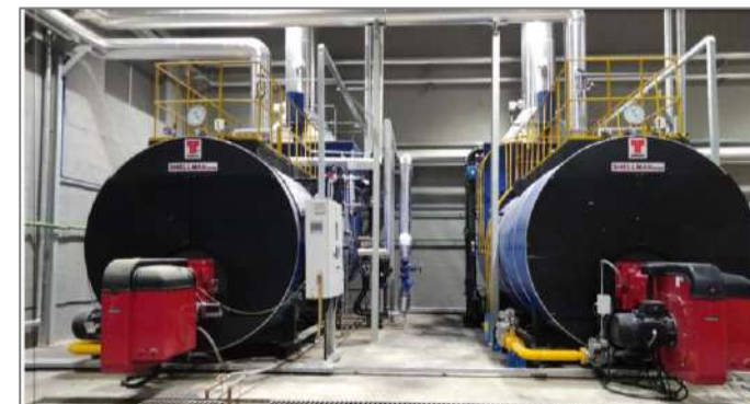
Nồi hơi Shellmax Global 2 X 8 TPH Chuyên ngành sữa Ả Rập Xê Út
