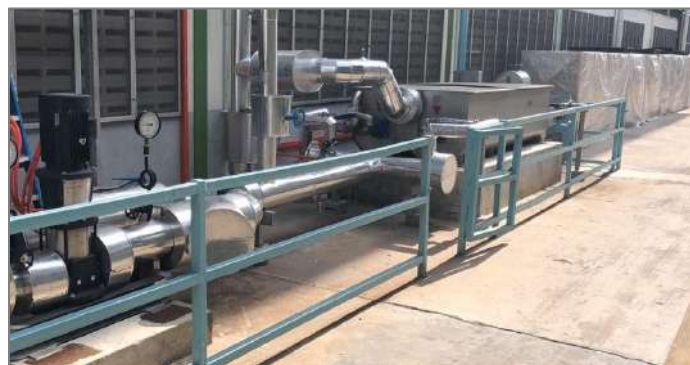
Bộ trao đổi nhiệt quay (thu hồi nhiệt từ nước thải) Nhà sản xuất cao su, Malaysia
