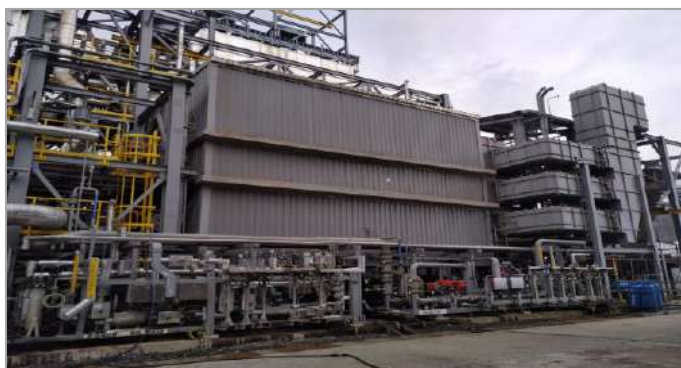
Nồi hơi đốt dầu và khí đốt 2 X 125 TPH Chuyên ngành hóa dầu Philippines
