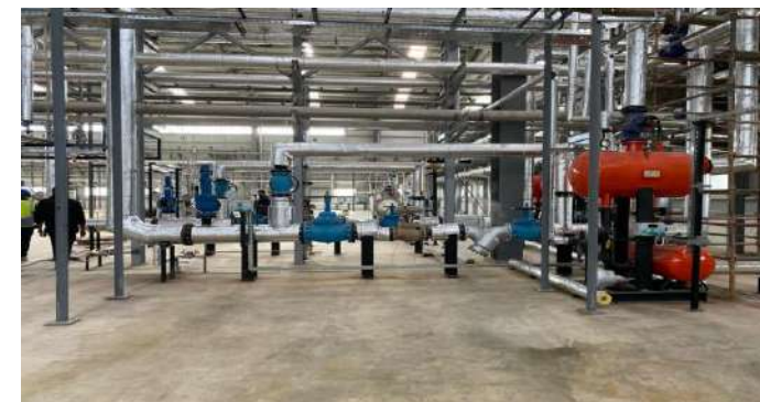
Hệ thống thu hồi nước ngưng nhỏ gọn (CPCRS) Chuyên ngành dệt may, Jordan
