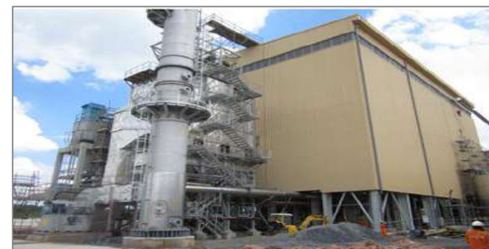
Nồi hơi đốt chất thải cà phê 25 TPH Chuyên ngành thực phẩm Việt Nam
