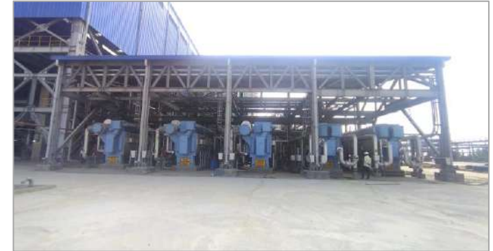
8 X 600 TR Máy làm lạnh hấp thụ đốt hơi nước một hiệu quả Nhà sản xuất phân bón, Ấn Độ
