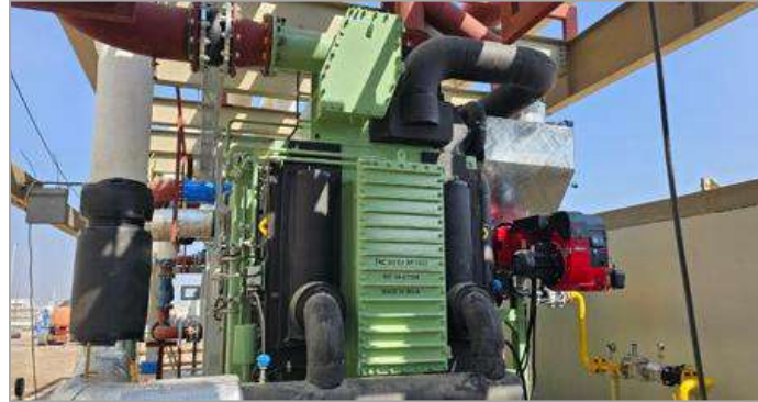
3 x 538 TR máy làm lạnh hấp thụ đốt khí hiệu ứng kép Công ty chế biến thực phẩm, Oman
