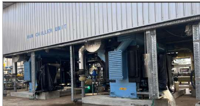
Máy làm lạnh hấp thụ bằng hơi nước hiệu ứng kép 2 x 800 TR Chuyên ngành hóa dầu, Nigeria
