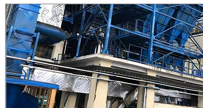
Nồi hơi Bì-drum 40 TPH Dược phẩm Indonesia
