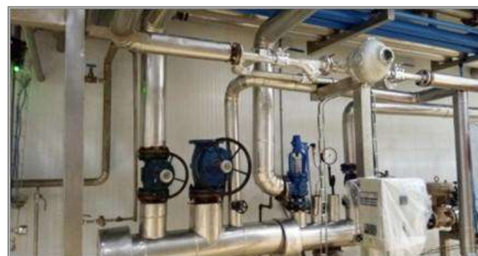
Bẫy hơi và mô-đun Nhà sản xuất ván ép Ấn Độ
