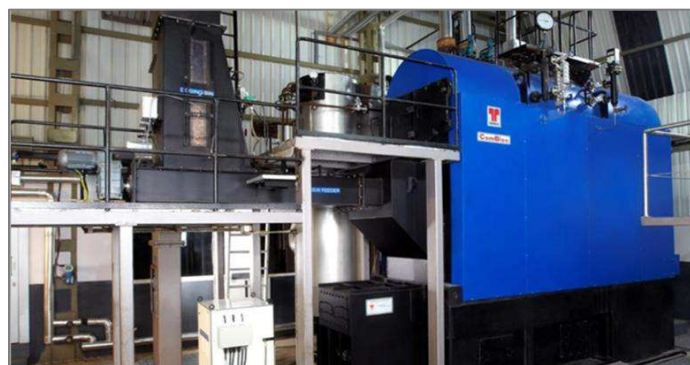
Nồi hơi 10 TPH Combloc Nhà sản xuất sản phẩm thảo dược Indonesia
